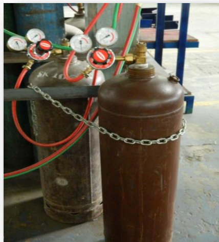
แสดงการยึดถังแก๊สด้วยโซ่เพื่อให้ความ ความแข็งแรง ปลอดภัยขณะใช้งานอย่างถูกวิธี
