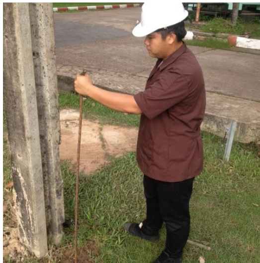
รูปที่ 10.4 การนำหลักดินมาใส่บริเวณที่จะทำหลักดิน
