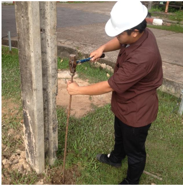
รูปที่ 10.5 การใช้ค้อนปอนด์ตอกหลักดิน
