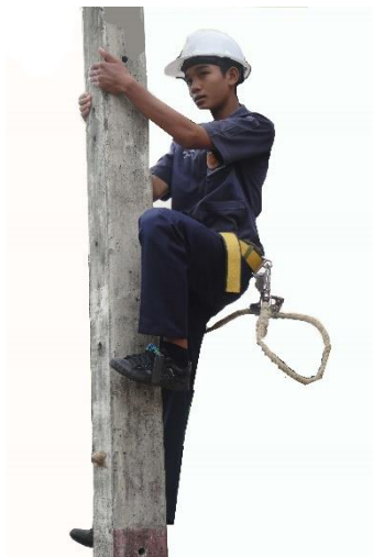
รูปการปีนเสาไฟฟ้า
