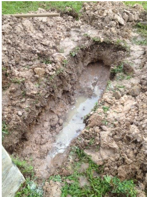
รูปที่ 9.1 การขุดหลุมเดินสายใต้ดิน
