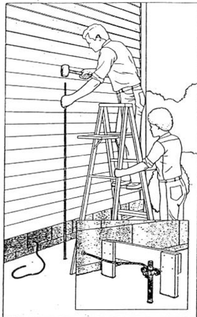
รูปที่ 10.2 การติดตั้งหลักดิน
