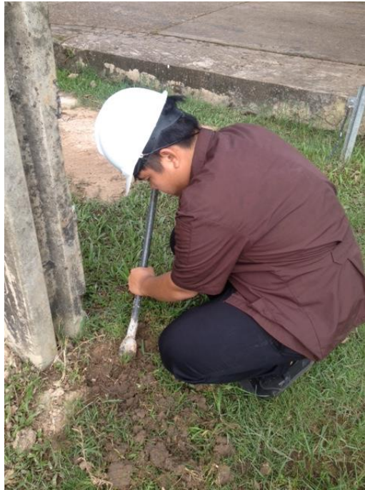
รูปที่ 10.3 ใช้เสียมมือขุดหน้าดินออก
