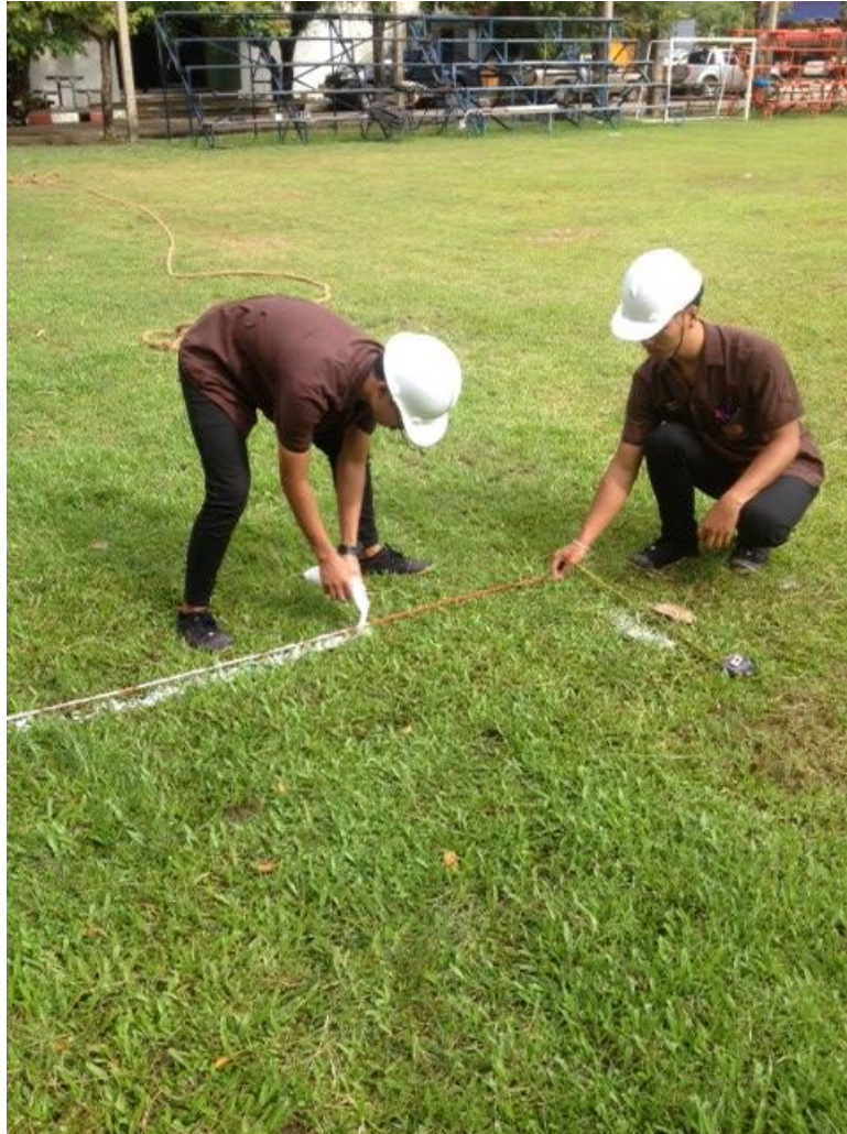
รูปที่ 9.2 การตีเส้นเป็นแนวสำหรับการขุดหลุม
