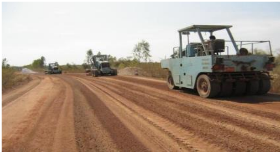
รูปที่ 4.23 แสดงการพรมน้ำบนชั้นทางเพื่อใช้คลุกเคล้ากับวัสดุถม
