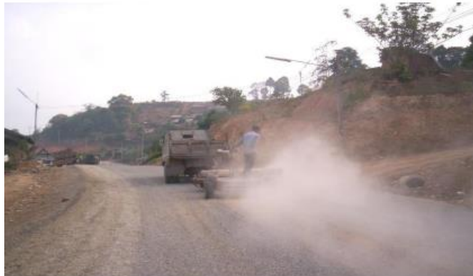
รูปที่ 7.1 แสดงการทำความสะอาดพื้นทางก่อนการลาดแอสฟัลต์
