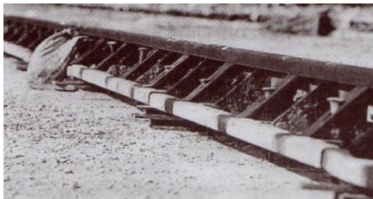
รูปที่ 7.19 แสดงการตั้งแบบหล่อเหล็กสำหรับถนนคอนกรีต
