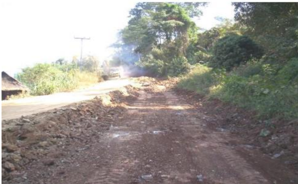
รูปที่ 4.10 แสดงงานตัดหน้าดินบริเวณที่จะทำการก่อสร้างถนน
