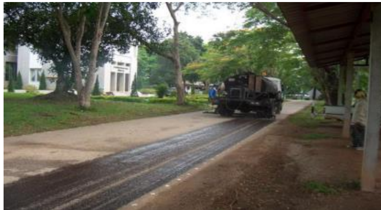
รูปที่ 7.9 แสดงการพ่น Prime Coat ด้วยเครื่องพ่นยาง
