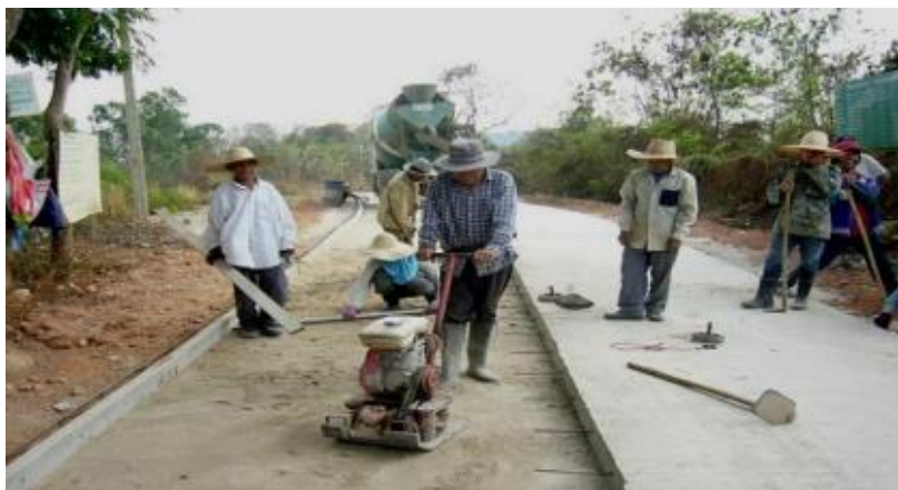
รูปที่ 7.25 แสดงการบอัดด้วยเครื่องบดอัดแบบเดินตาม
