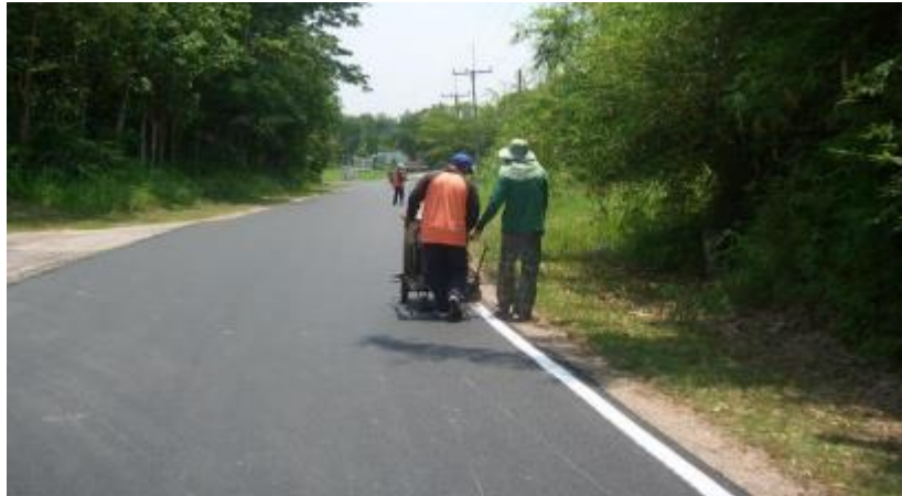
รูปที่ 7.12 แสดงการตีเส้นจราจรเครื่องตีเส้น
