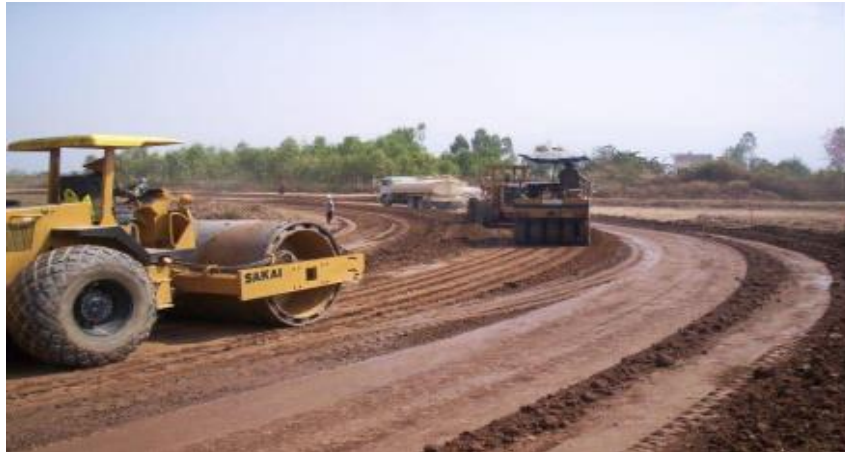
รูปที่ 4.26 แสดงการบดอัดชั้นวัสดุถมให้ได้ความแน่นตามที่กำหนด
