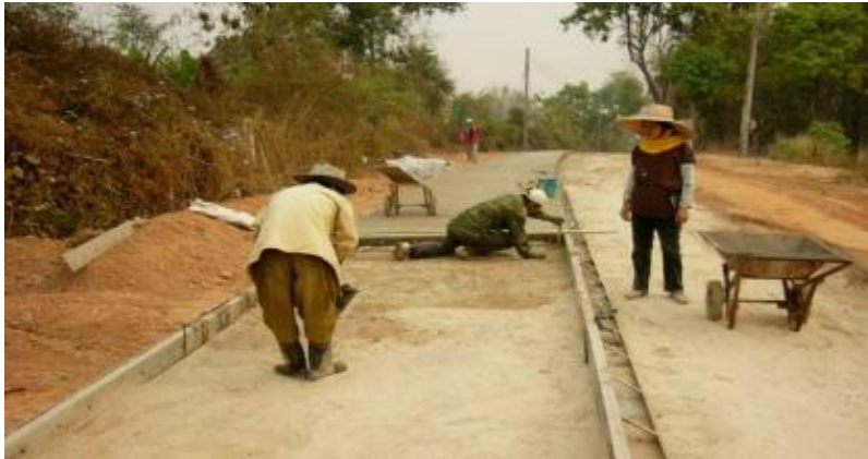
รูปที่ 7.24 แสดงการตบแบบและปรับระดับทรายรองฐานแบบ
