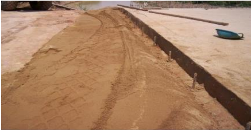
รูปที่ 4.22 แสดงการบดอัดบริเวณคอสะพานให้ได้ความแน่นที่กำหนด
