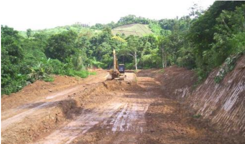
รูปที่ 4.9 แสดงการขุดแต่งหน้าดินบริเวณที่จะทำการก่อสร้างถนน
