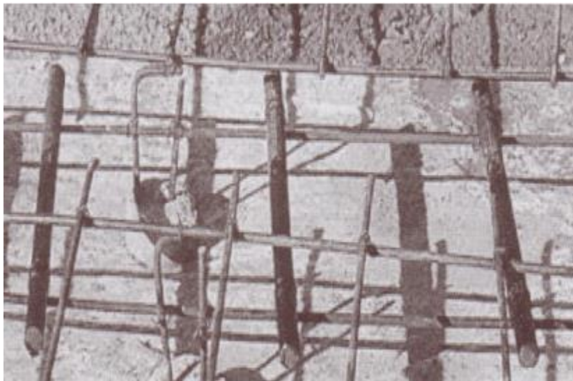
รูปที่ 7.17 แสดงเหล็กเดือย (Dowel Bar)
