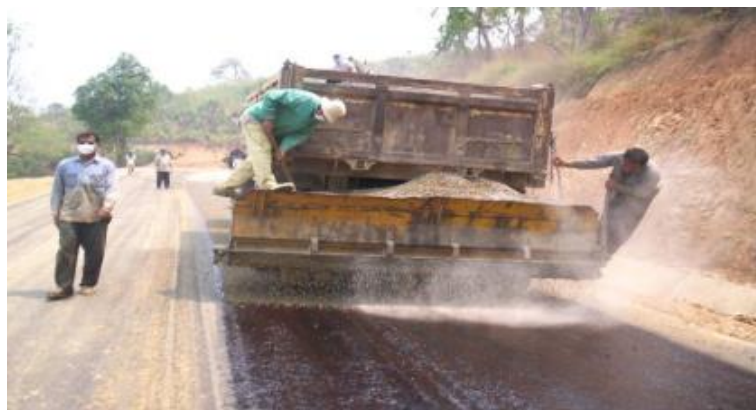
รูปที่ 7.5 แสดงการโรยหินด้วยเครื่องโรยหิน
