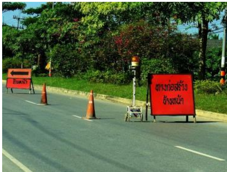
รูปที่ 4.1 แสดงการติดตั้งป้ายเตือนในเขตก่อสร้างทาง
