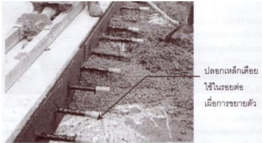
รูปที่ 7.18 แสดงปลอกเหล็กเดี่ยว (Dowel Bar)
