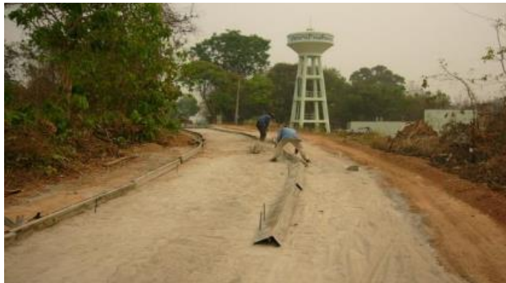
รูปที่ 7.20 แสดงการเตรียมแบบหล่อเหล็กสำหรับถนนคอนกรีต
