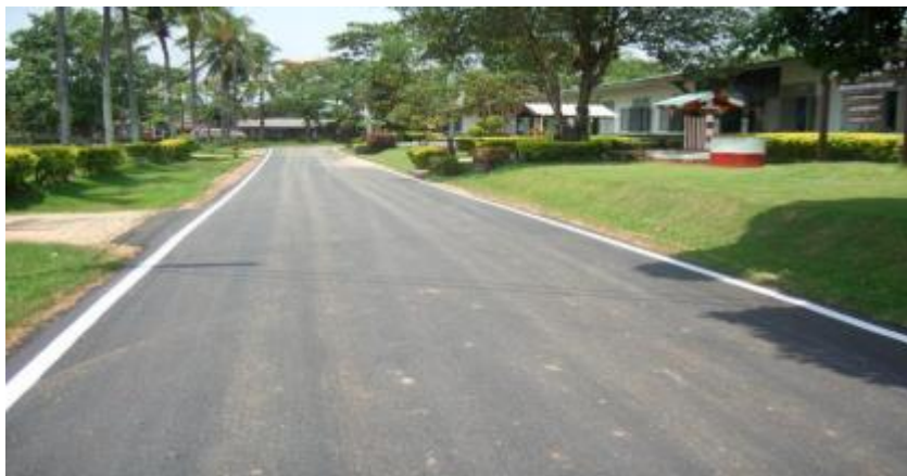
รูปที่ 7.13 แสดงผิวทางแบบแอสฟัลต์คอนกรีต เมื่อตีเส้นจราจรแล้ว
