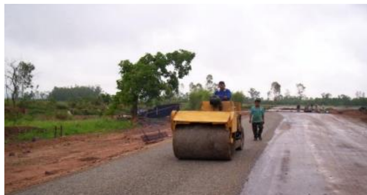
รูปที่ 7.6 แสดงการบดอัดด้วยเครื่องบดอัด
