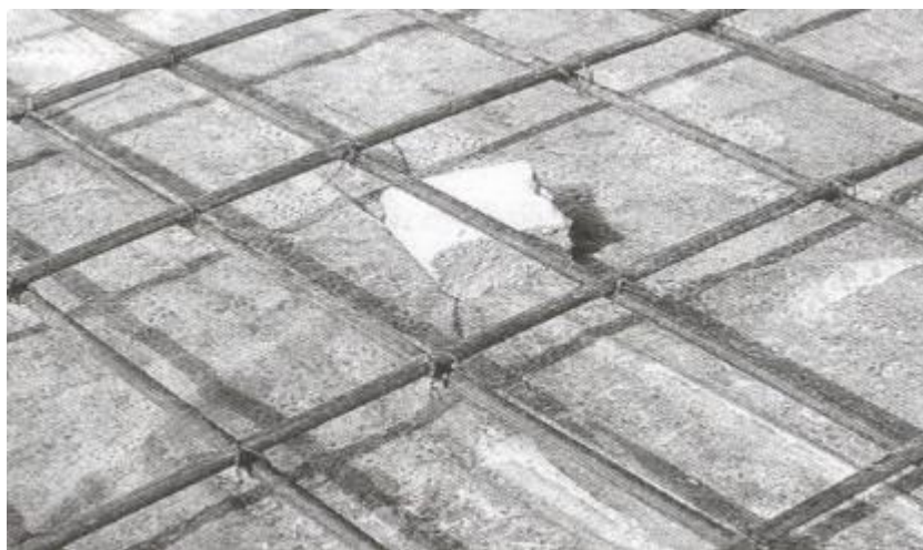
รูปที่ 7.30 แสดงการเทคอนกรีตชั้นเดียว (วางเหล็กก่อน)
