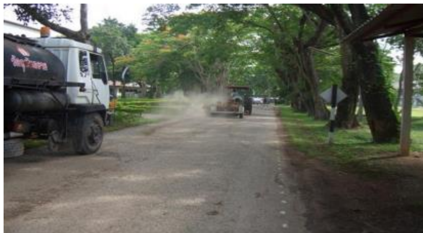
รูปที่ 7.8 แสดงการทำความสะอาดก่อนการพ่น Prime Coat
