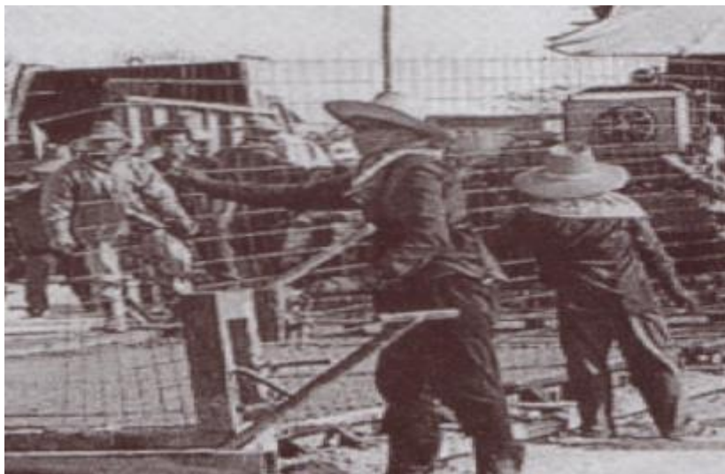
รูปที่ 7.31 แสดงการวางเหล็กตะแกรงของถนนคอนกรีต (วางเหล็กที่หลัง)
