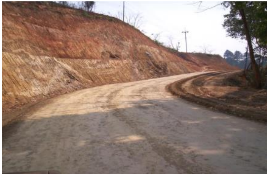
รูปที่ 4.21 แสดงการตัดลาดเชิงเขา เป็นแบบขั้นบันได (Benching)
