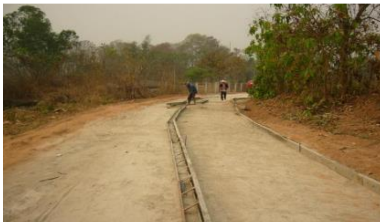
รูปที่ 7.21 แสดงการตั้งแบบที่จะเทคอนกรีตให้ได้ระยะทางอย่างน้อย 50 เมตร
