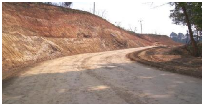
รูปที่ 7.2 แสดงการเตรียมพื้นทางก่อนการลาดแอสฟัลต์
