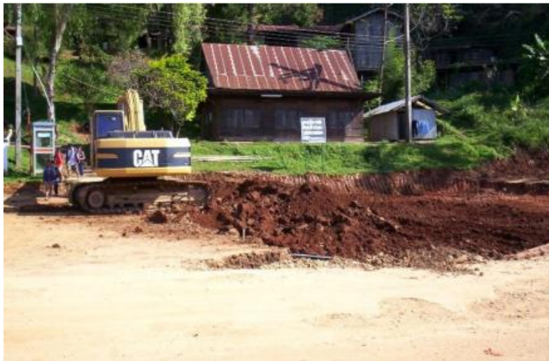
รูปที่ 4.11 แสดงการขุดดินไม่เหมาะสมและมีคุณภาพต่ำกว่าชั้นทาง
