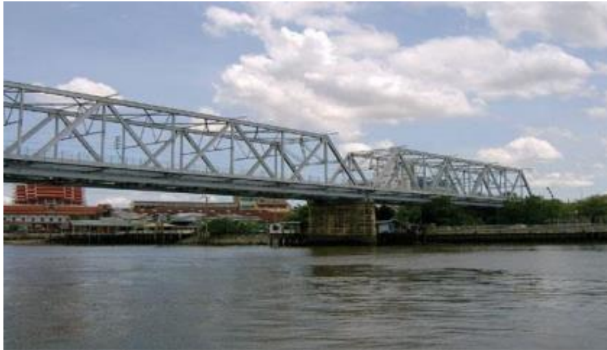
รูปที่ 6.12 แสดงสะพานเหล็ก
