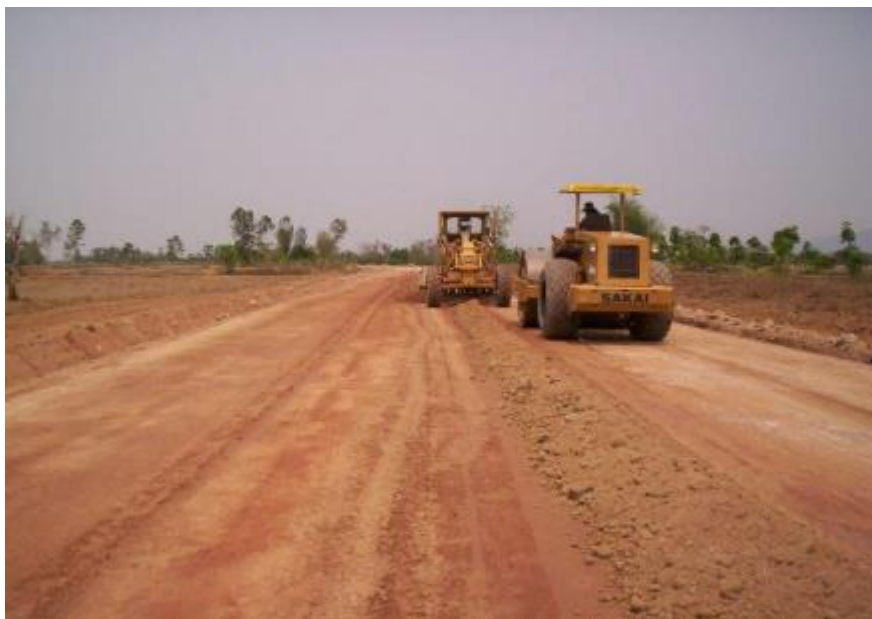
รูปที่ 4.25 แสดงการปรับแต่งระดับของชั้นวัสดุถมแต่ละชั้นให้ได้ตามกำหนด
