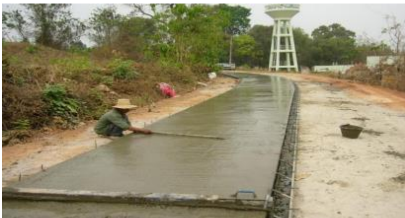
รูปที่ 7.26 แสดงการปรับผิวหน้าคอนกรีต
