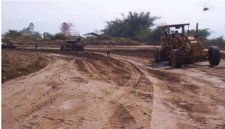
รูปที่ 4.24 ใช้รถเกรดเตอร์ตีแผ่เกลี่ยวัสดุคลุกเคล้าผสมให้มีปริมาณน้ำที่เหมาะสม
