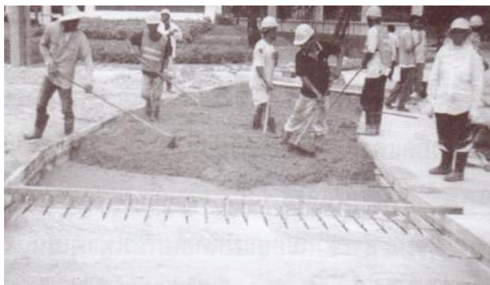
รูปที่ 7.32 แสดงการเกลี่ยคอนกรีตที่เทแล้วให้แผ่กระจายอย่างสม่ำเสมอ
