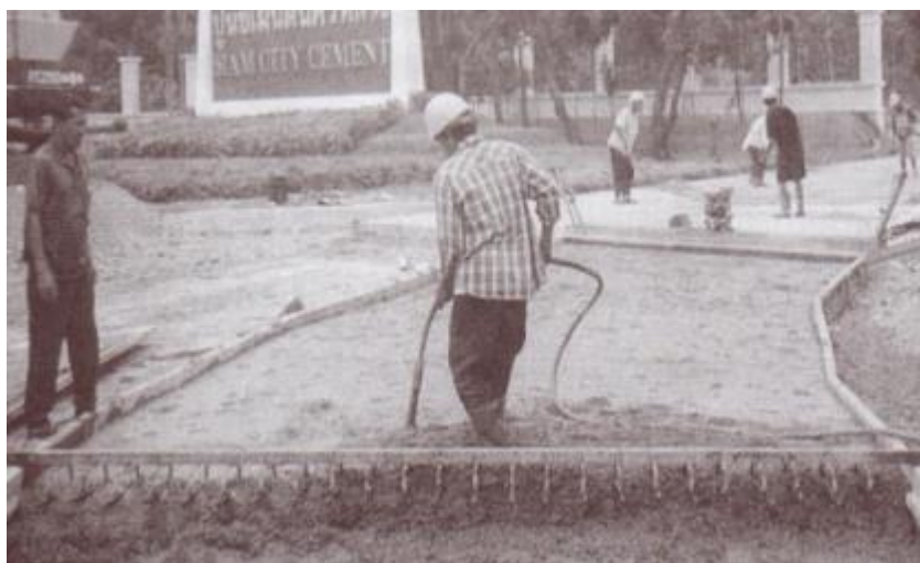
รูปที่ 7.33 แสดงการใช้เครื่องสั่นสะเทือนกดลงในคอนกรีตเพื่อให้คอนกรีตยุบตัวมีเนื้อแน่นและเต็มตลอดผิวหน้าของแบบหล่อ
