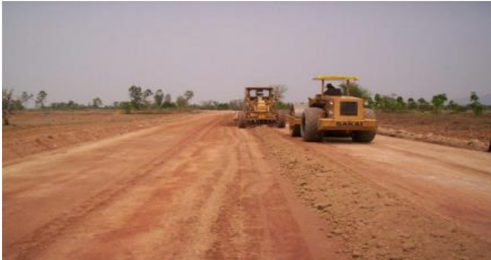
รูปที่ 4.18 แสดงการเกลี่ยเป็นชั้นบาง ๆ และบดทับให้ได้แนวระดับ
