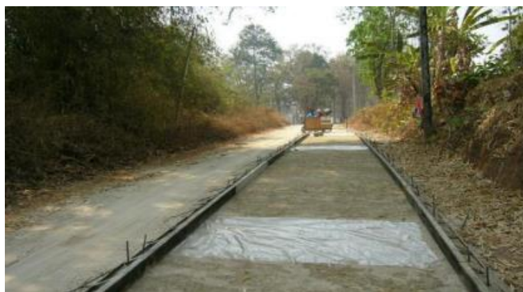
รูปที่ 7.22 แสดงการปูแผ่นพลาสติกตรงรอยต่อของแผ่นคอนกรีต
