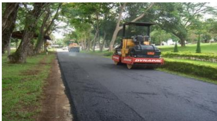
รูปที่ 7.11 แสดงการบดอัดทางแบบแอสฟัลต์คอนกรีตด้วยเครื่องบด
