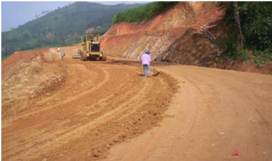
รูปที่ 4.13 แสดงการขุดคู้ ลึก 15 เซนติเมตร
