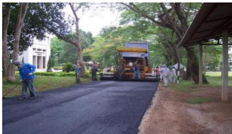
รูปที่ 7.10 แสดงทำผิวทางแบบแอสฟัลต์คอนกรีตด้วยเครื่องปูยาง
