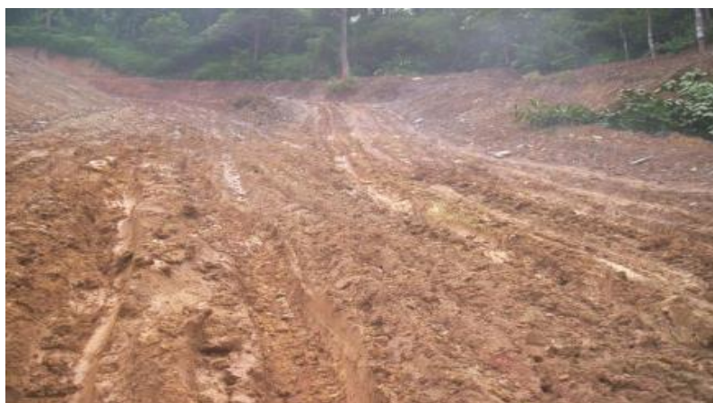
รูปที่ 4.12 แสดงงานขุดบริเวณของคันทางเดิมซึ่งดินอ่อนตัว
