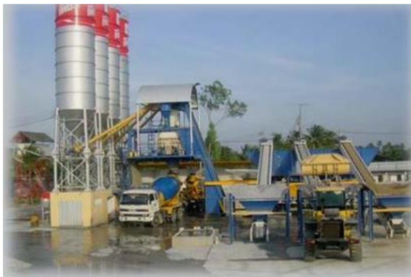
รูปที่ 7.27 แสดงโรงผสมคอนกรีต
