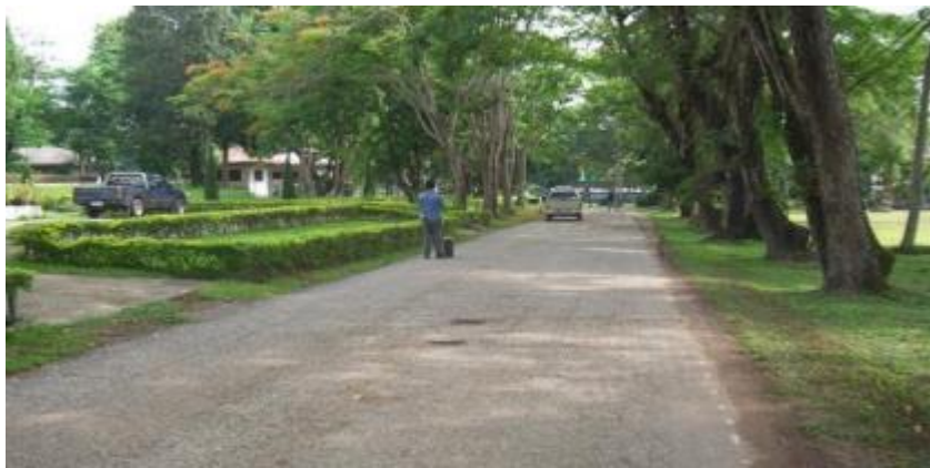
รูปที่ 7.7 แสดงผิวถนนเดิมก่อนทำผิวทางแบบแอสฟัลต์คอนกรีต
