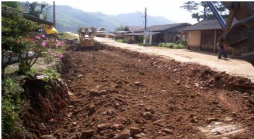
รูปที่ 4.5 แสดงการขุดดินต่ำกว่าระดับดินเดิมไม่น้อยกว่า 30 เซนติเมตร
