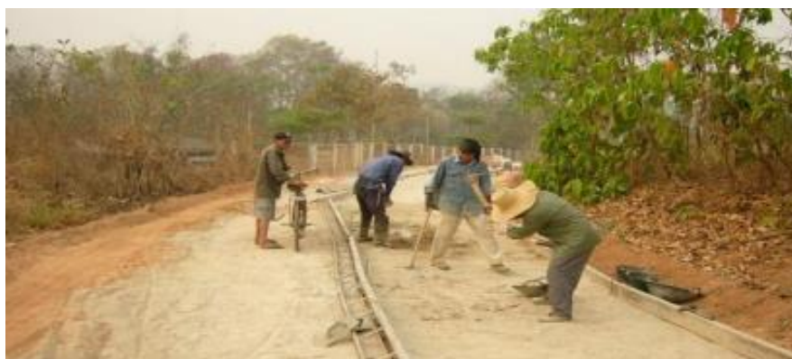
รูปที่ 7.23 แสดงการตั้งแบบและปรับระดับ
