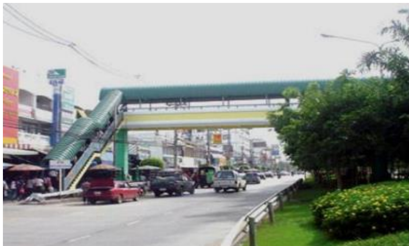
รูปที่ 6.14 แสดงสะพานคอนกรีตอัดแรงข้ามถนน
