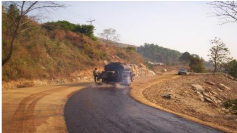
รูปที่ 7.4 แสดงการลาดยางครั้งแรก ด้วยเครื่องลาดยาง
