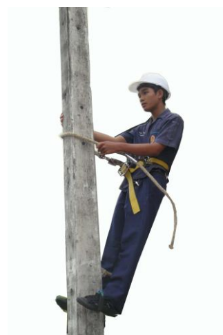
รูปการคล้องที่ยึดตัวขณะยืนบนเสาไฟฟ้า
